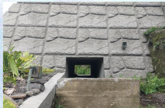
壩體動物通道出入口
