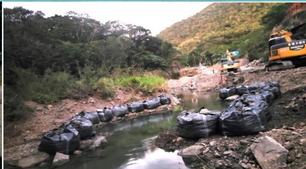
設置臨時沉砂池
