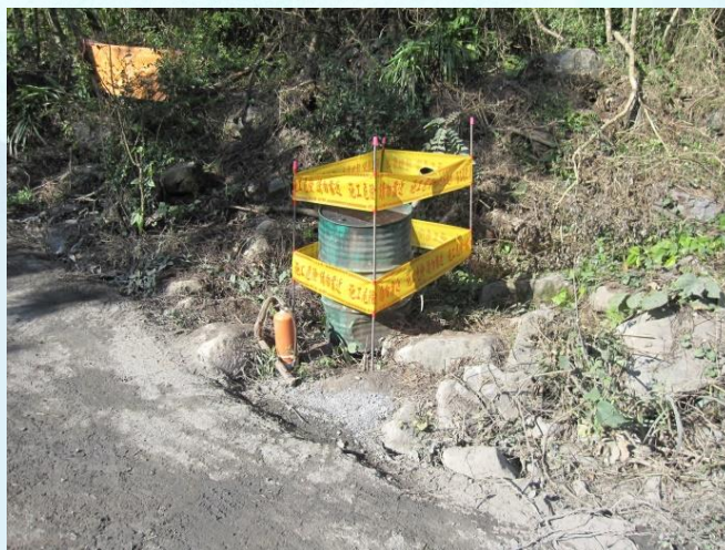
油料專區及滅火器
