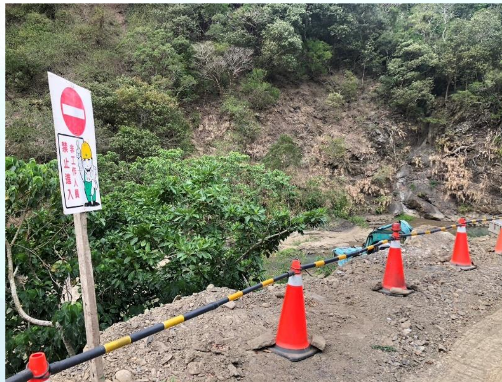
施工便道警告標示明確
