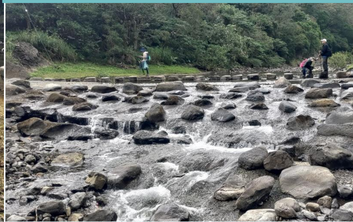
混凝土塊石鋪面磨蝕塊石脫落
