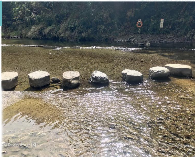
混凝土塊石鋪面破損斷裂
