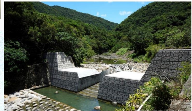
未完工的屏東雙流國家森林遊樂區雙流溪壩體改善工程，壩體補強延壽外，最大亮點是為減輕河川生態阻隔，導入生態友善措施，打造斜坡式鋪石魚道等多項友善動物生態廊道。圖/屏東分署提供
