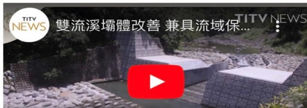
未完工的屏東雙流國家森林遊樂區雙流溪壩體改善工程，壩體補強延壽外，最大亮點是為減輕河川生態阻隔，導入生態友善措施，打造斜坡式鋪石魚道等多項友善動物生態廊道。圖/屏東分署提供
