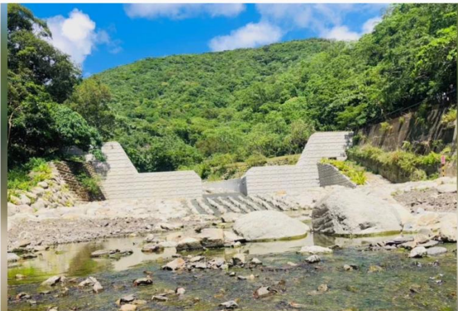
未完工的屏東雙流國家森林遊樂區雙流溪壩體改善工程，壩體補強延壽外，最大亮點是為減輕河川生態阻隔，導入生態友善措施，打造斜坡式鋪石魚道等多項友善動物生態廊道。圖/屏東分署提供
