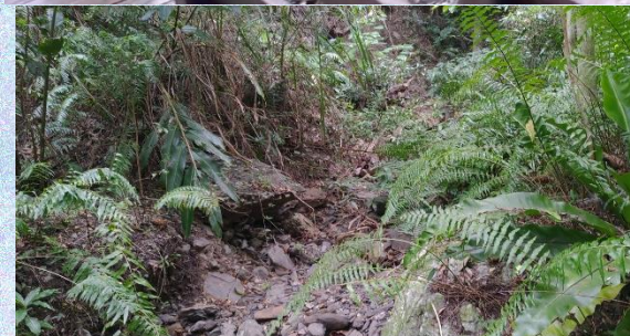
坑溝側岸沖刷
