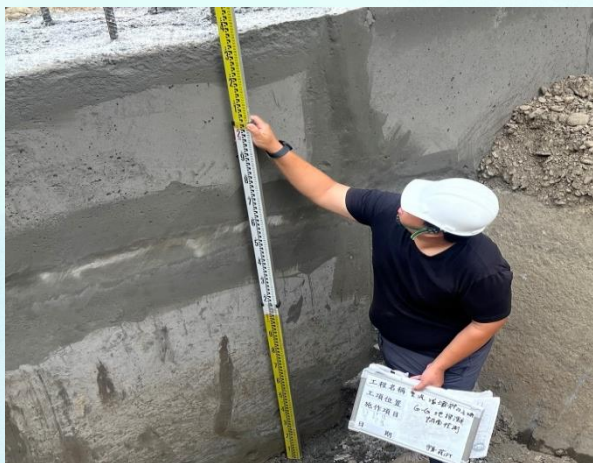
斜曲面地樑完成面尺寸檢查
