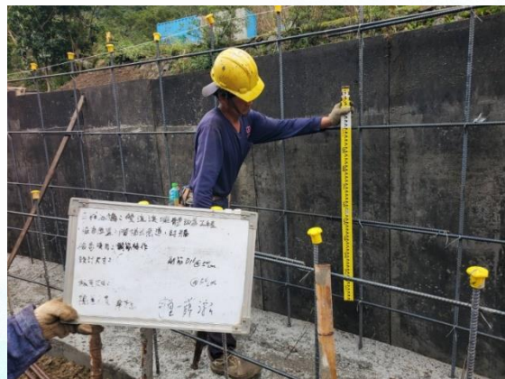
塊石水域廊道鋼筋間距檢查
