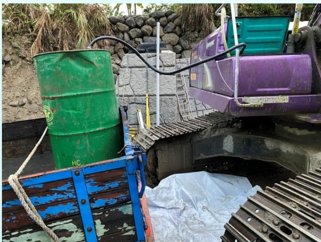
油料補充下方加鋪防火墊
