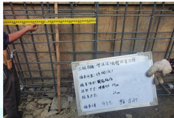
斜曲面地樑鋼筋組立搭接長度檢查
