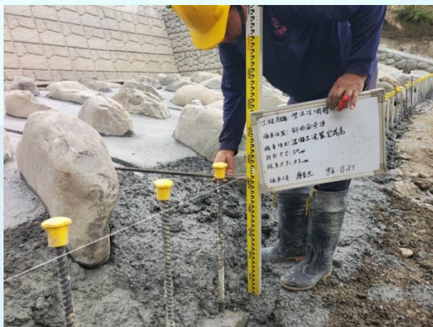
斜曲面水域廊道鋪面厚度檢查
