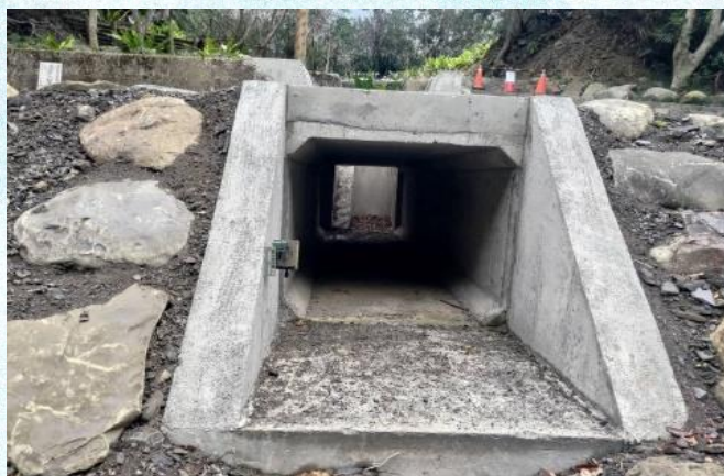
坑溝動物通道出入口
