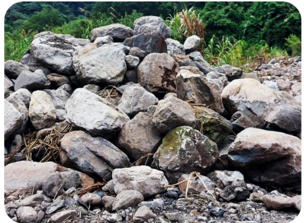
雪山坑下游防砂壩整建工程
