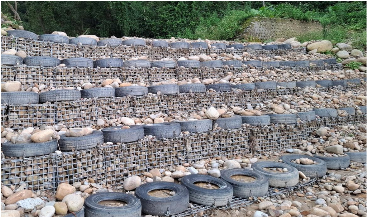
圖 4-6 箱型石籠示意圖
