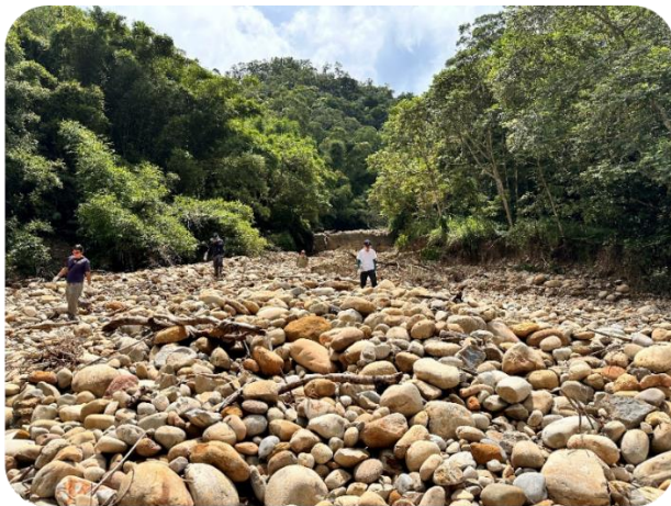
大安溪1林班石頭坑溪防砂設施修復工程
