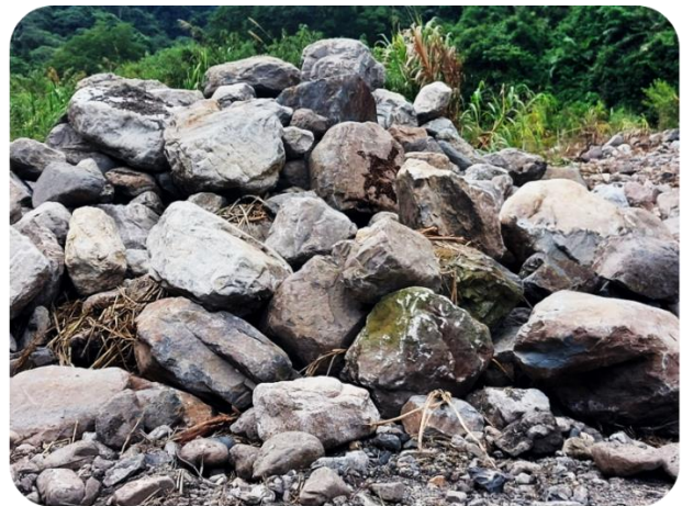
雪山坑下游防砂壩整建工程
