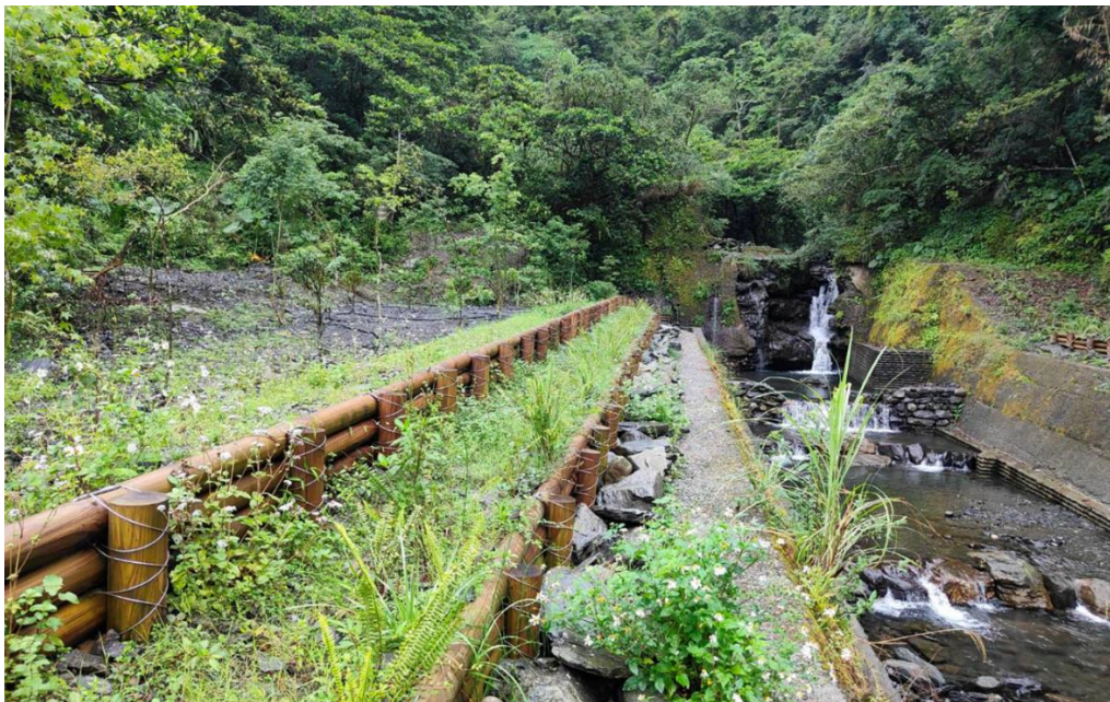
工程名稱：翻社坑溪 A 支坑整治工程
