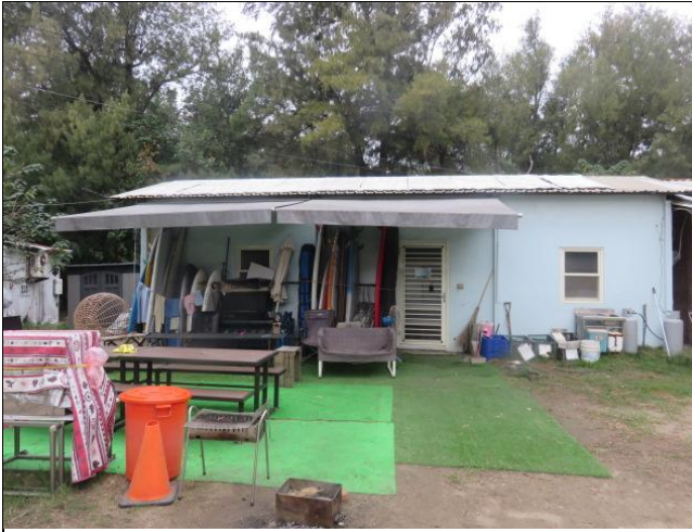
887-7 地號現場照片
