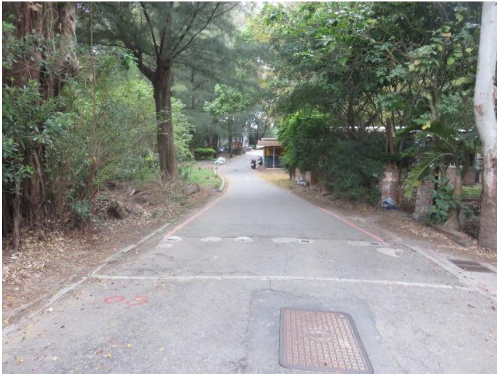
287-2063 之內、877 之內、887 之內、1273 之內、1274 之內、1275 之內、1276 之內、未登記地等 8 筆地號現場相片(道路)
