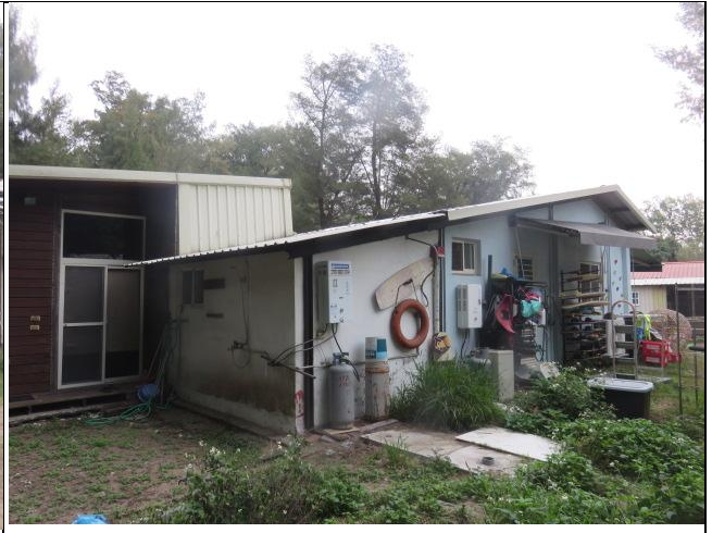
887-7 地號現場照片
