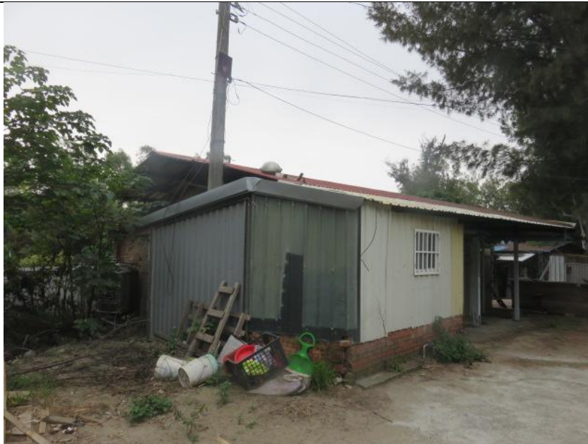
887-3 地號現場照片
