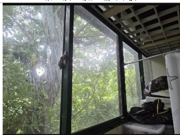
張貼前(主場館 2 樓儲藏室)
