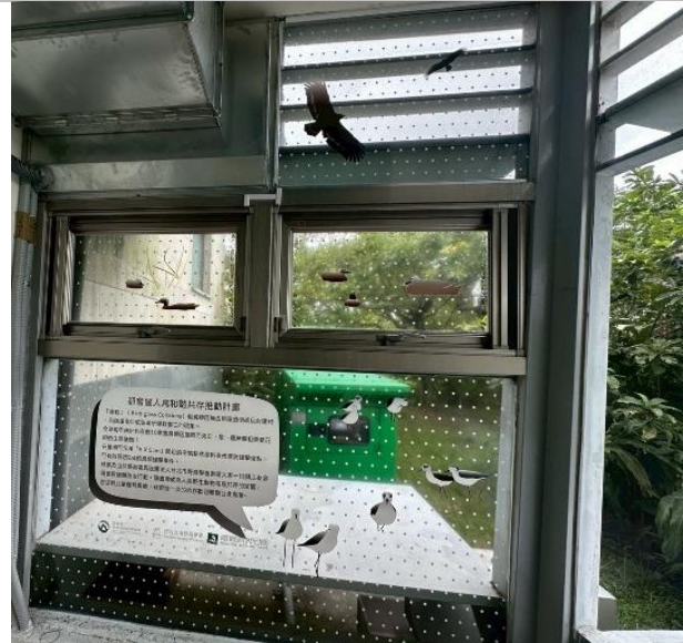
1 樓內側張貼後 2
