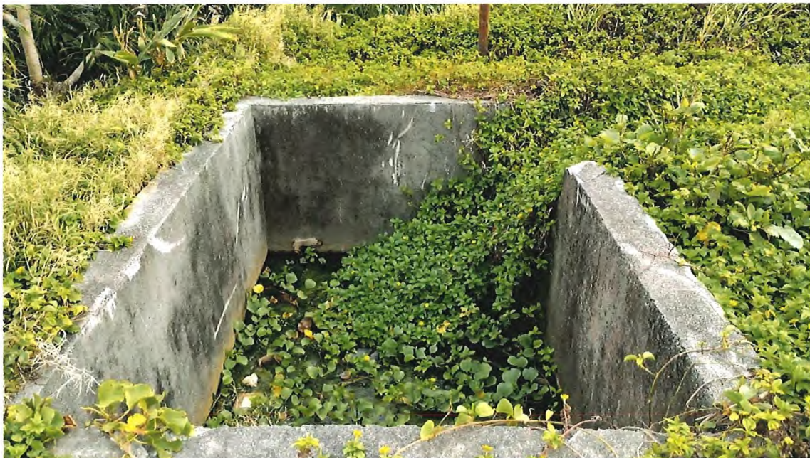
臺東縣綠島鄉公館東段1344-1(2) 地號上蓄水池
