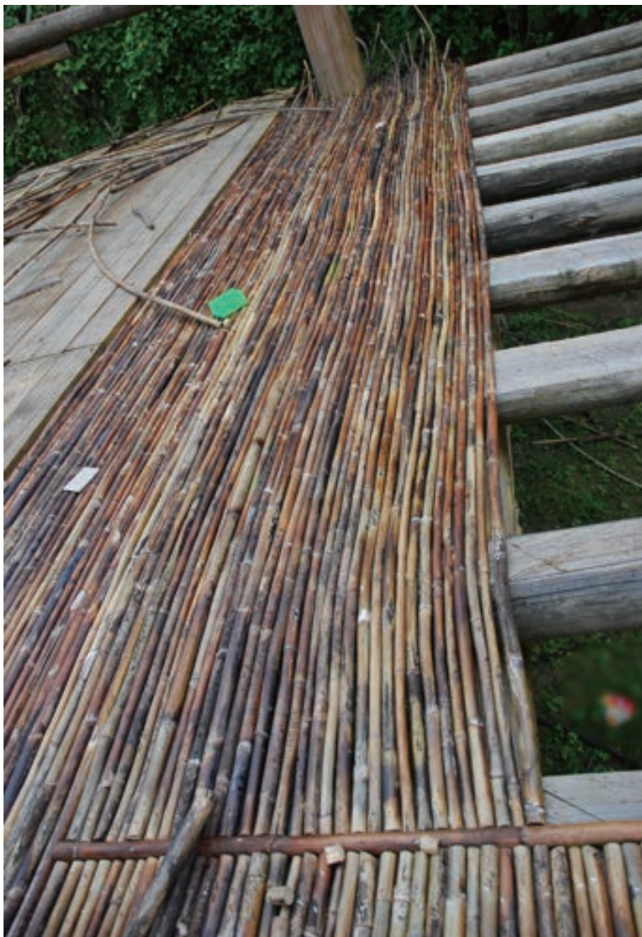
黃藤做的地板既堅固又耐用 The yellow rattan palm floor is sturdy and durable.
