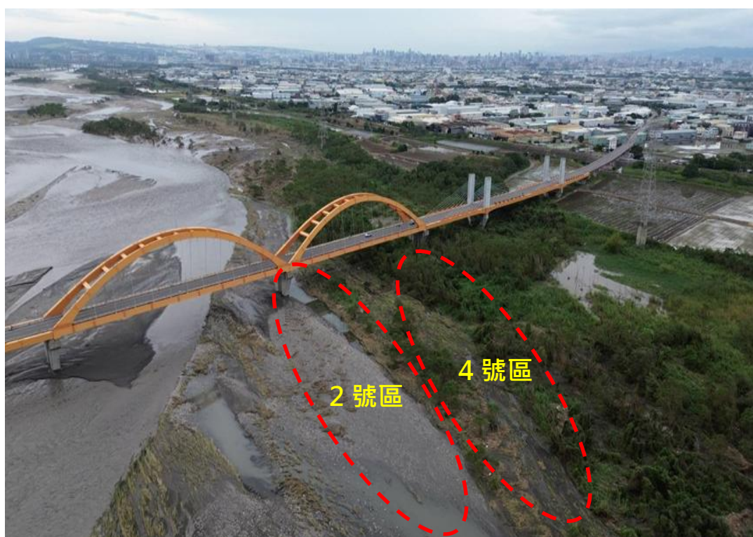
圖 2、溪尾大橋 2 號區及 4 號區於凱米颱風後之狀況(2024.07.27 拍攝)
