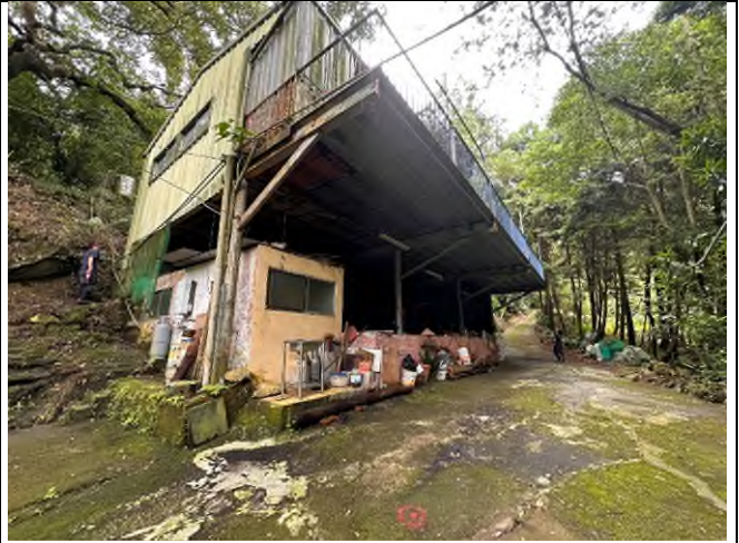
臺中市太平區塔湖段1地號土地利用現況照片
