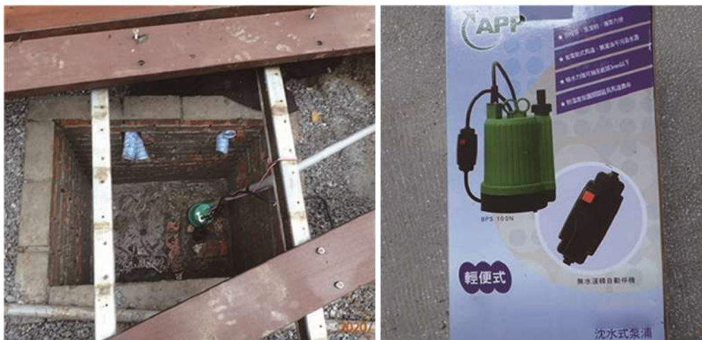
圖 9-28、簡易動力排水井設置實務；安裝小型浮球式沉水泵即可。
