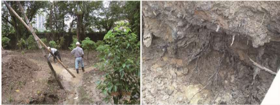
圖 9-8、土壤長期浸潤，導致樹木根系壞死、腐敗發臭。
