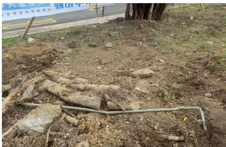
圖 9-6、基地土壤常因人為干擾混雜營建廢料及各種垃圾，對樹木生長具相當的影響。
