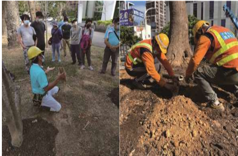
圖 9-19、在樹木根系有效吸收範圍挖掘豎洞，並埋入輔助通透的管材，可增加土壤通透作用。上圖係利用竹管為埋設材料，因竹管為可降解材，對環境更具友善優勢。
