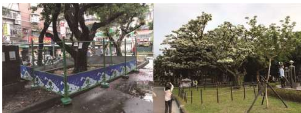
圖 14-39、為避免施工造成樹木損傷，以圍籬設立樹木保護範圍。
