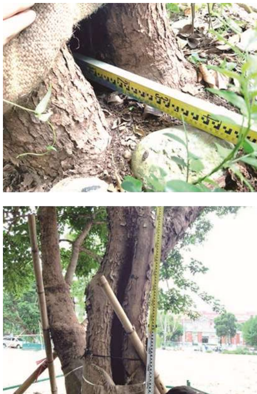
圖 6-17、透過照片說明該樹根領及主幹處具大面積開放傷口、空洞外，可藉由比例尺(箱尺)輔助，進而得到根領處水平空洞約 20cm，主幹空洞垂直延伸近 270cm 等資訊。
