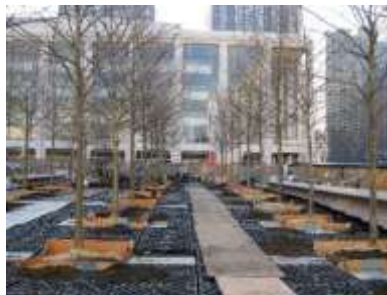
圖 9-18、在栽植基地安裝結構支撐裝置，以承受並分散人員在基地上活動時所產生的衝擊，降低基地土壤受夯壓導致硬化，有助於樹木根系生長。(圖片來
