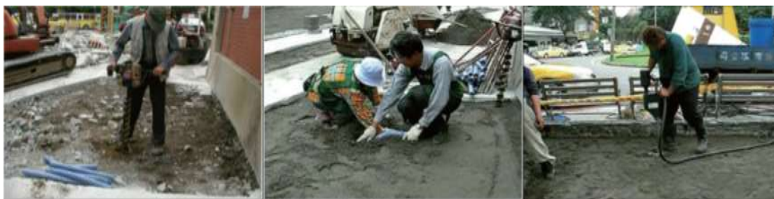
圖 9-38、表土整平、埋設透氣管線；利用高壓氣爆進行深層鬆土，以改善土壤狀態。
