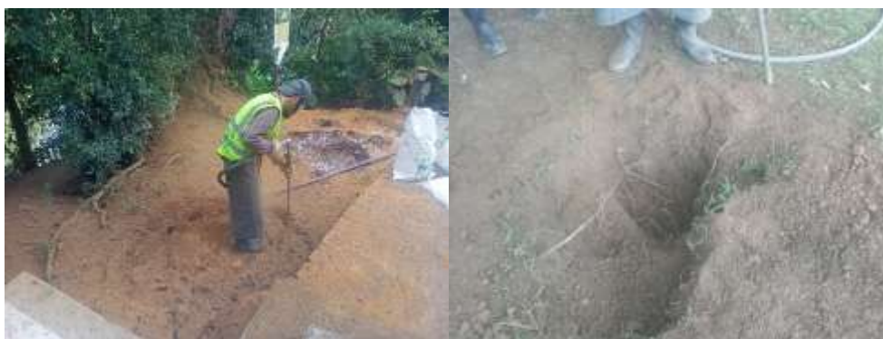
圖 9-21、由產學合作開發的新工法，利用高壓噴氣吹翻土壤，使根系裸出，再回填改良土方，達到基地改良的目的。
