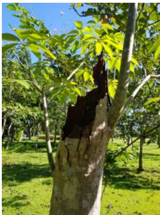
圖 10-17、截幹修剪造成的傷口腐朽會讓不定枝的結合力弱化。
