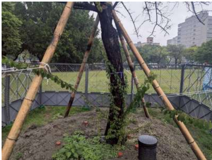
圖 11-7、樹木周邊設置通氣管。
