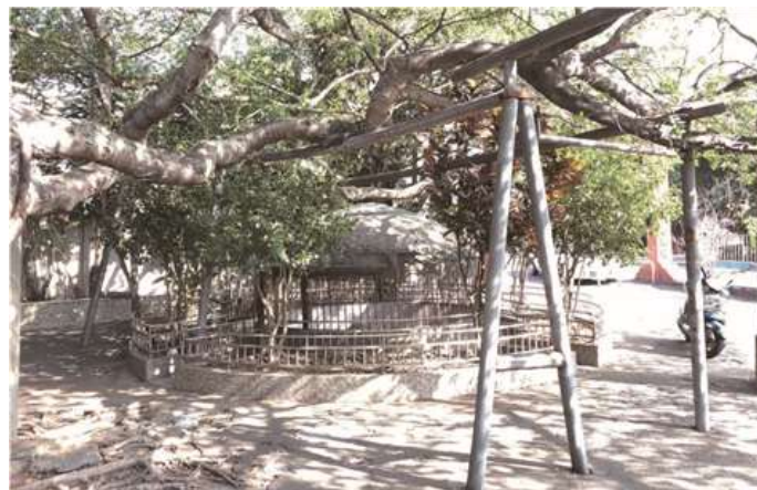
圖 5-5、支架強度不足而變形。
