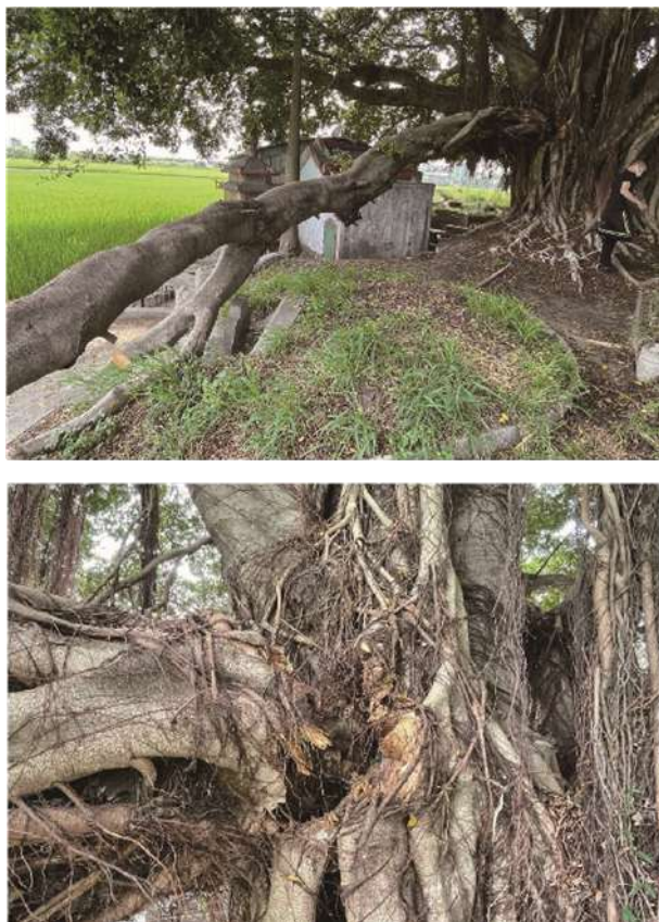
圖 5-1、枝條過長加上連接處腐朽，無法支撐自身重量而折損。(上&下圖)
