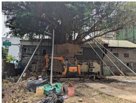
圖 6-35、受保護樹木斷根後支撐作業。
