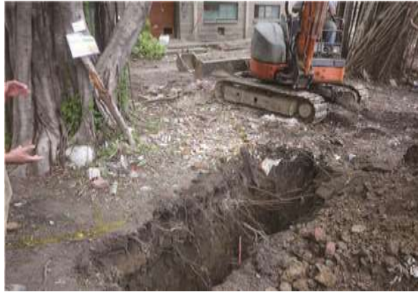
圖 6-28、斷根挖掘作業。
