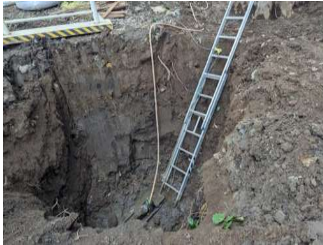
圖 6-49、若地下水位過高，根球底部土壤吸水飽和，與根球上部土壤重量不均，吊運過程中易造成根球土壤崩裂。
