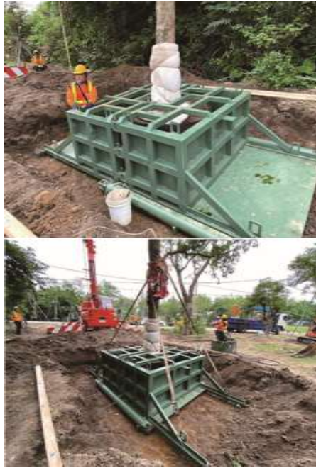
圖 7-8、鋼製底板配合油壓力道，強壓伸入土球(根球)底部進行切斷底根及土方
