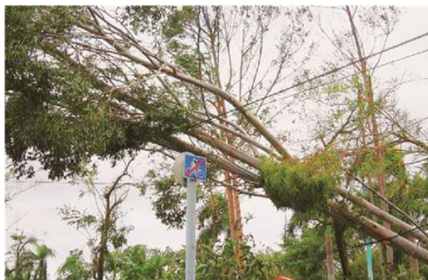
圖 1-44、樹木塌壞使主要輸配電線系統的中斷可歸類為重大後果。
