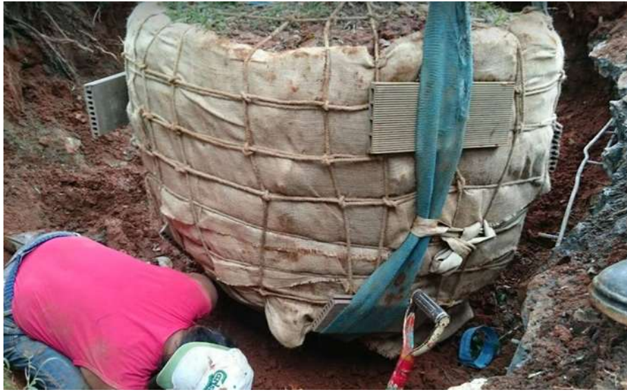
圖 7-16、纖維吊帶施力內側增設支點墊片
