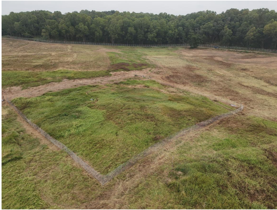
圖 3.2-2、畜試所草鴉巢區安全圍網施工完成(114 年 1 月 13 日)
