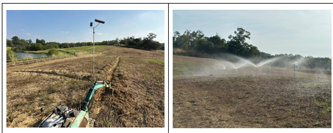
圖 3.3-16、人工澆溉系統設置前後現場比較
