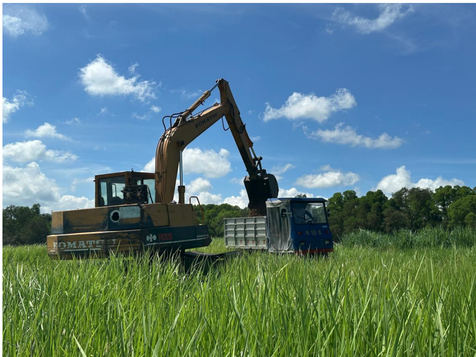
圖 3.3-11、白茅機具種植法-怪手配合搬運車及鏟裝機協同作業
