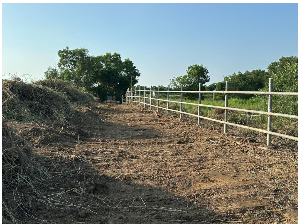
圖 3.3-4、草鴉棲地營造試驗區灌溉取水近岸整理施工現場
