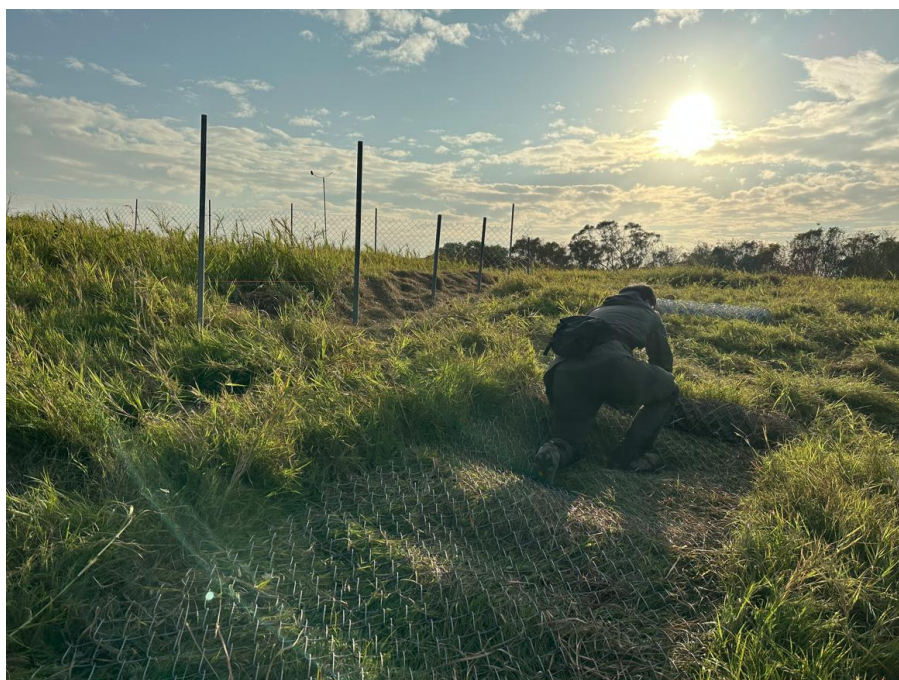
圖 3.2-1、圍網材料使用菱形網和鉸管進行架設工作
