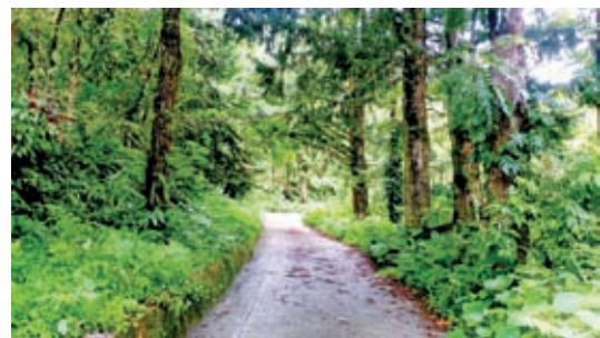
▲ 中平林道改善工程
