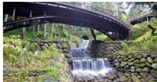
▲ 第16屆金質獎優等獎-嘉義林區管理處香林橋下游野溪整治工程
