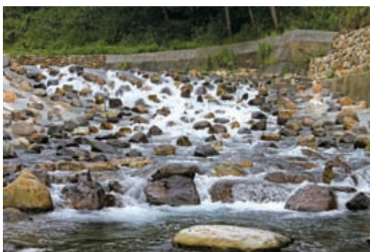
▲ 橫流溪野溪下游整治工程
