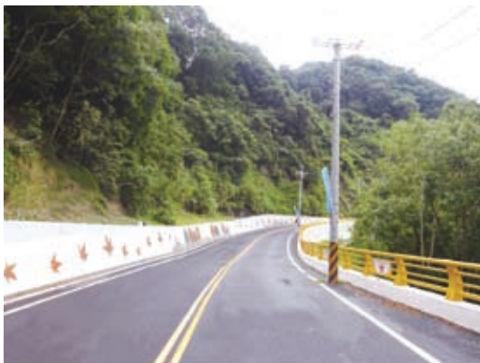
▲ 奧萬大聯外道路改善工程
