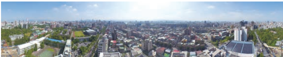
▲ 和平辦公大樓頂樓環景圖
