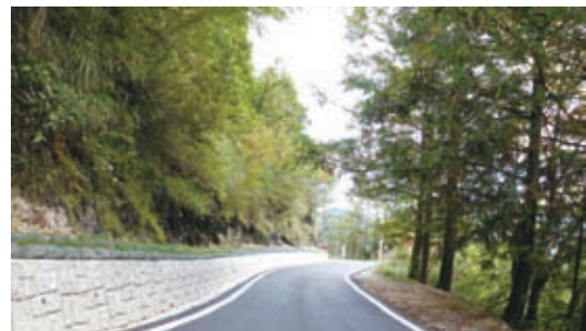
▲ 樂山林道改善工程
