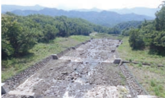
▲ 玉井區第51林班芋仔寮坑野溪整治工程
