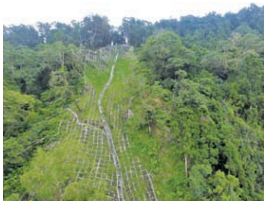
▲ 宜專一線5.1K上邊坡崩塌地處理工程
