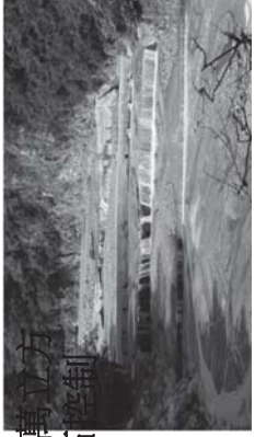
104年11月24日1號主壩頂，逐漸磨損，降低高度
