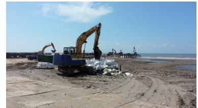
因工程開發造成藻礁生態價值的損失。圖片來源：桃園在地聯盟
