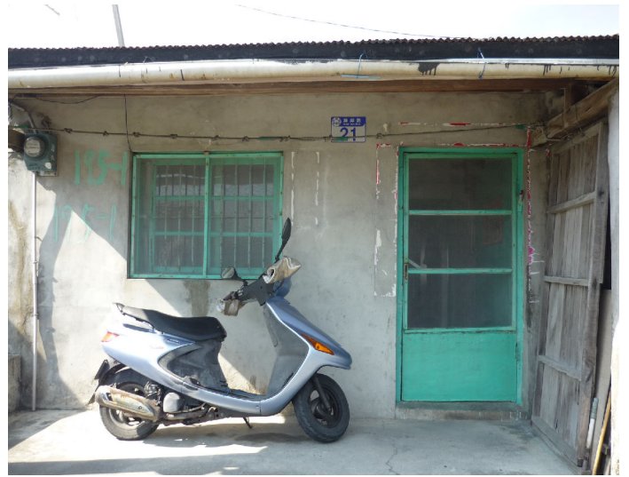
現況照片(海岸路21號)
