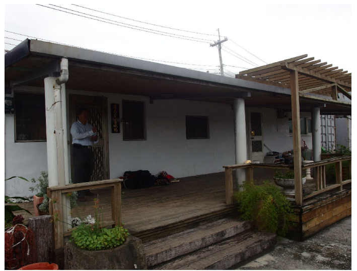
現況照片(海岸路32號)
