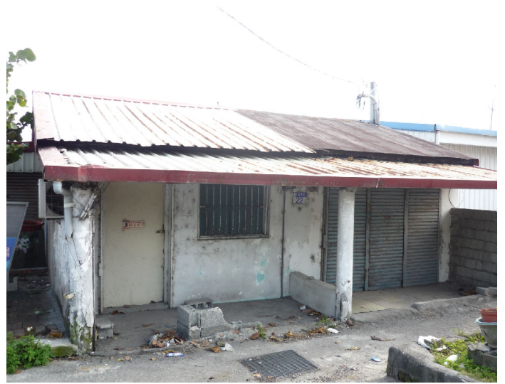
現況照片(海岸路22號)
