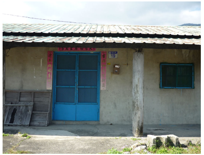
現況照片(海岸路19號)
