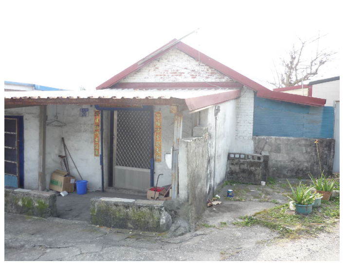
現況照片(海岸路20號)
