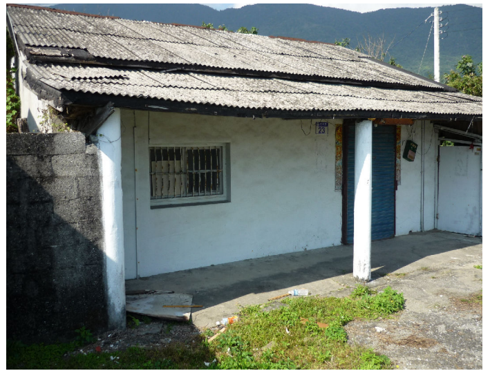
現況照片(海岸路23號)
