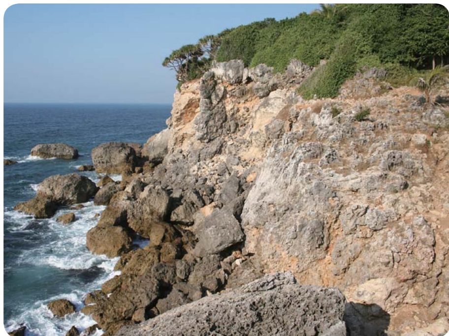
▲ 柴山西側接鄰台灣海峽，坡腳受海浪直接拍打等作用失去支撐力，上部的岩塊掉落堆積於海崖邊。
