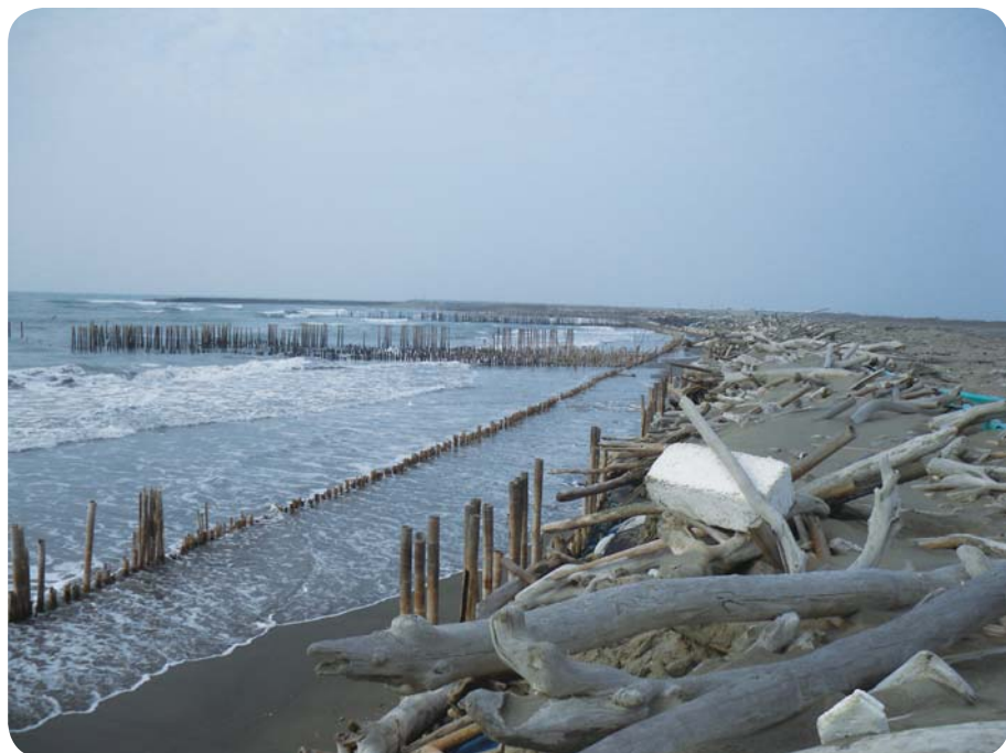
▲ 離岸沙洲，左側是台灣海峽海域，另一側則面臨潟湖與台灣本島。照片中豎立之木樁，是為防止沙洲流失的人工護岸工程。
