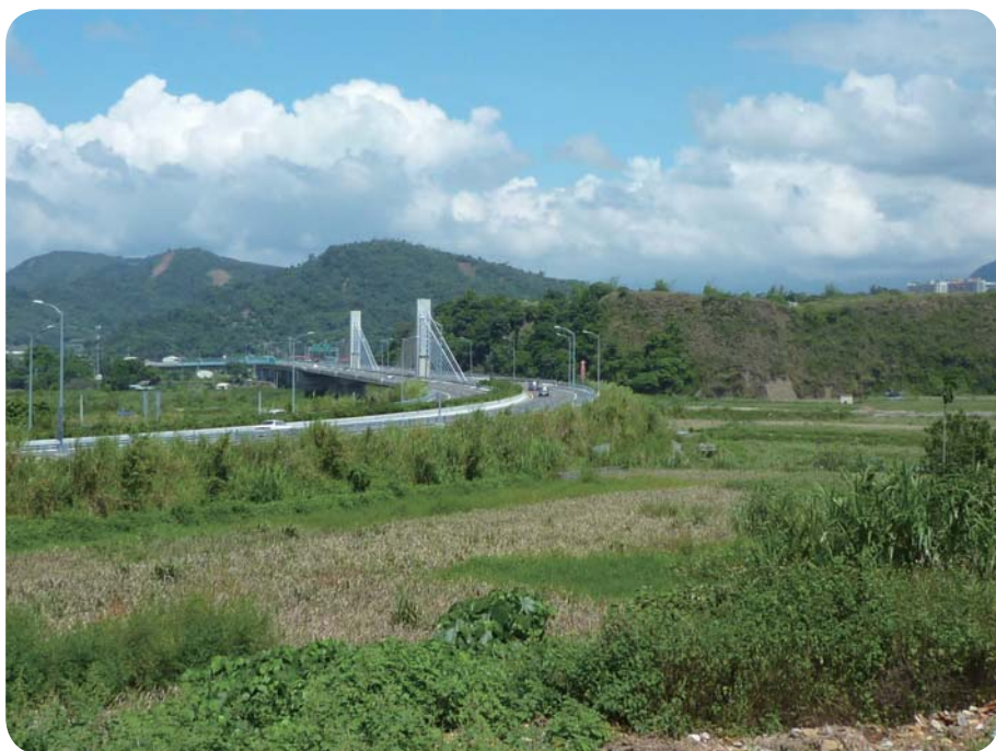
▲ 愛蘭台地呈西北西-東南東方向伸展高出河床約30公尺，外形像是一艘開進港口的大船守候在盆地入口，因此埔里人稱其為「船山」。
