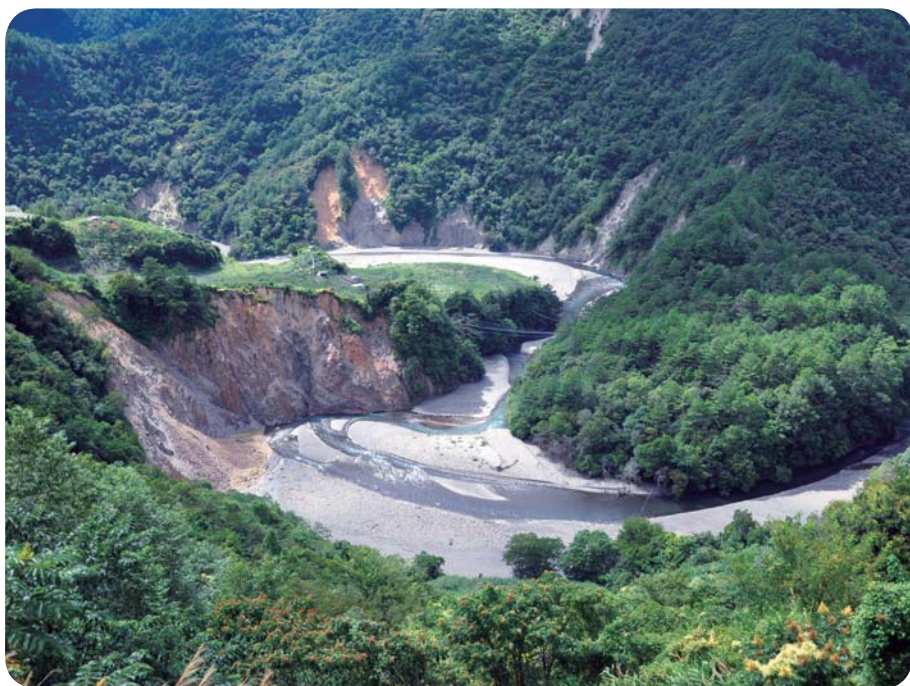
▲ 本地景為曲流侵蝕所形成的曲流階地，其右側為河流的攻擊坡，受強烈沖刷已導致大規模的侵蝕崩塌現象。
