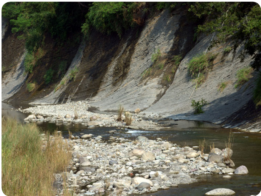
▲ 北溪河床有泥岩與薄層砂頁互層的蕃薯寮層出露，並可發現都巒山層的崩積岩塊。
