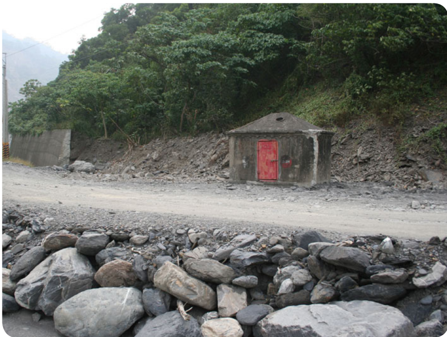
▲ 二峰圳的地下暗渠入口。
