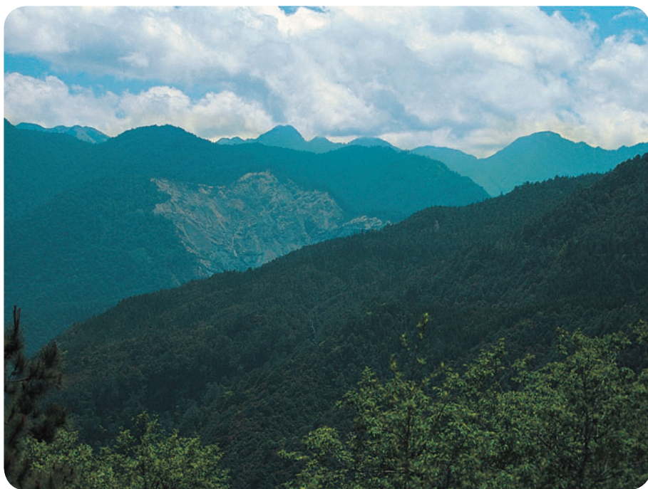
▲ 由觀霧山莊即可見到此崩塌地上半部所出露的白冷層剖面。
