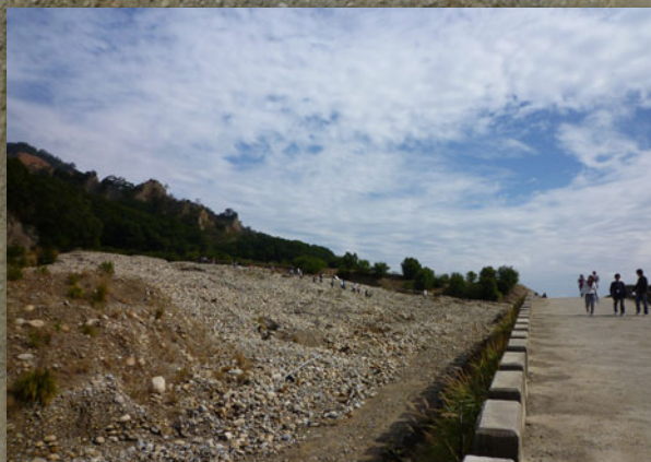
火炎山的礫石自然的堆積在隧道前，隧道設計的目的在於不干擾礫石的搬運堆積，當礫石量堆積高過隧道後會自然漫過隧道上方，而不影響道路的通行
