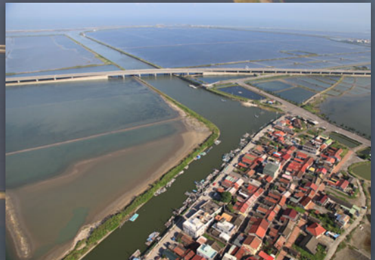
台南七股的七寮聚落，位於七股潟湖的北端。照片的左半部為七股鹽田舊址，為西部洲潟海岸的開發留下歷史見證
