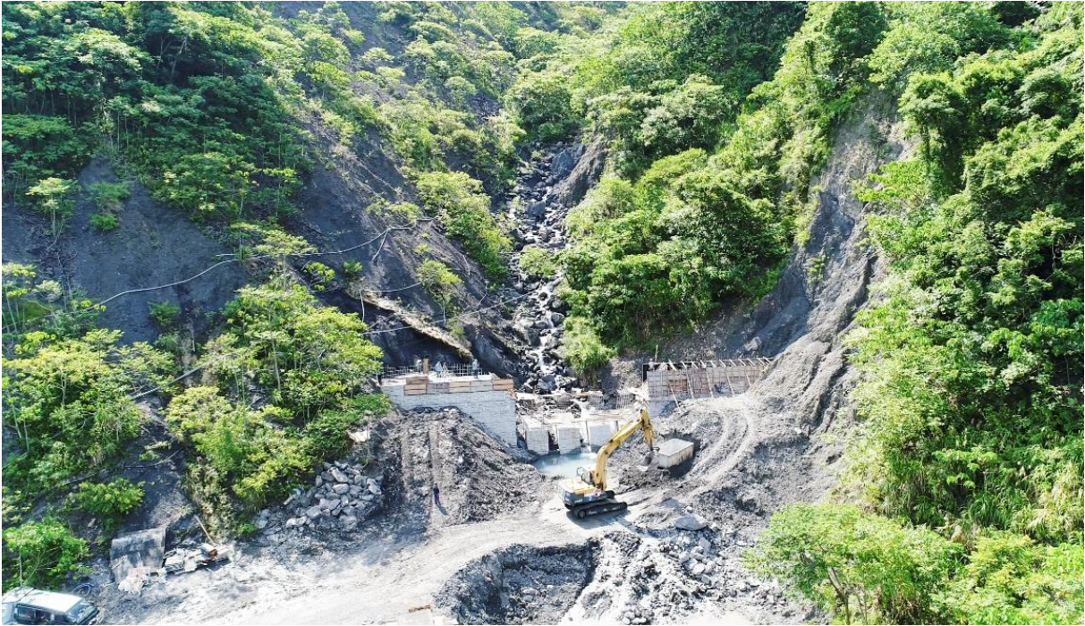
圖 4-13 北側蝕溝攔砂壩工程(106.7.14)
