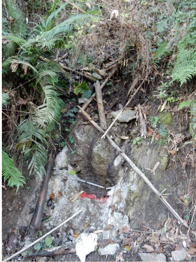
圖 4-26 美崙山步道邊坡地下水出露
