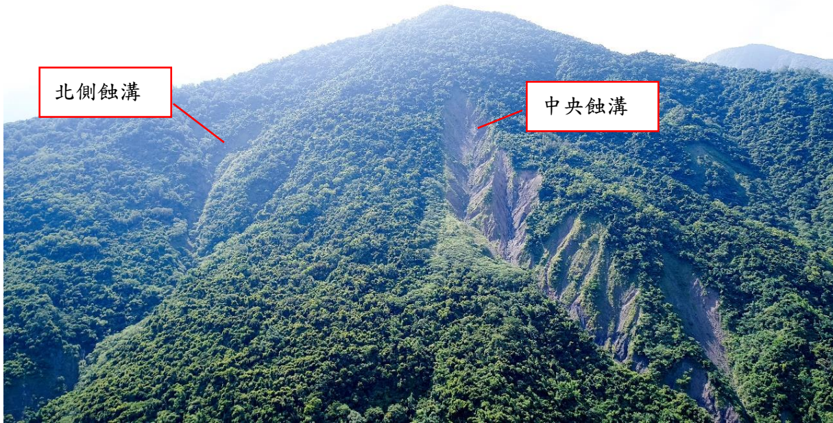
圖 4-11 中央蝕溝與北側蝕溝崩崖照片(106.7.14)
