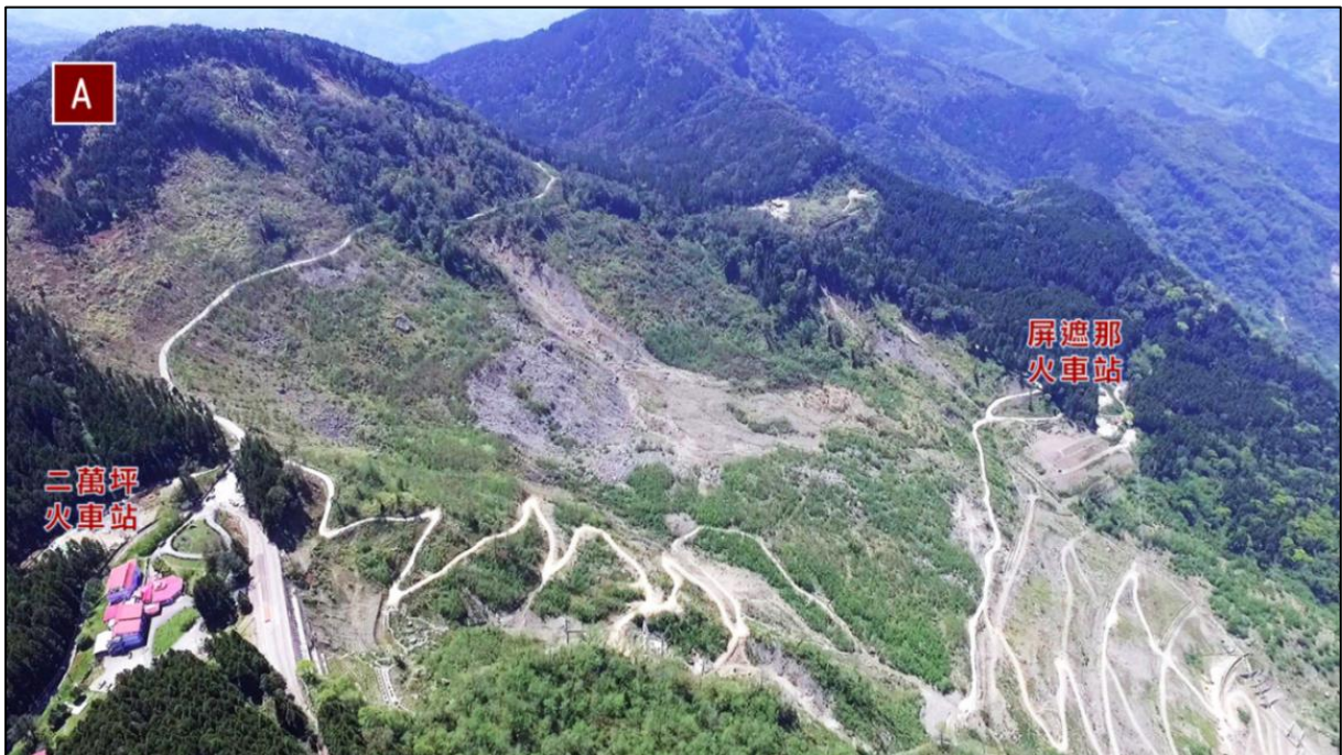
圖 3-52 二萬坪工區現地踏勘空拍照片-方向 A
