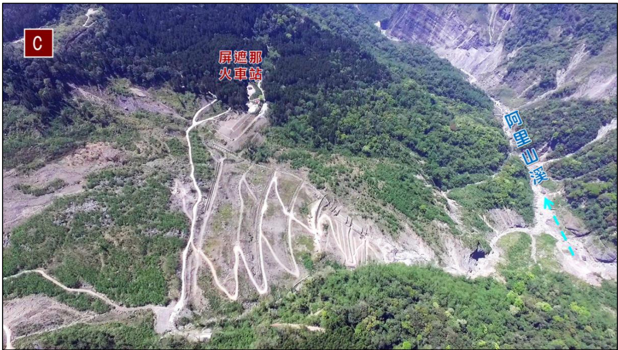
圖 3-54 二萬坪工區現地踏勘空拍照片-方向 C
