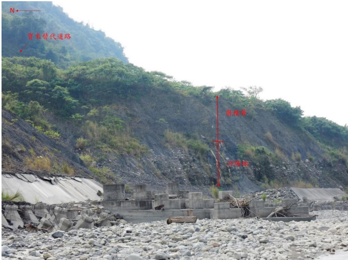
圖 4-24 階地與上覆的崩積層
