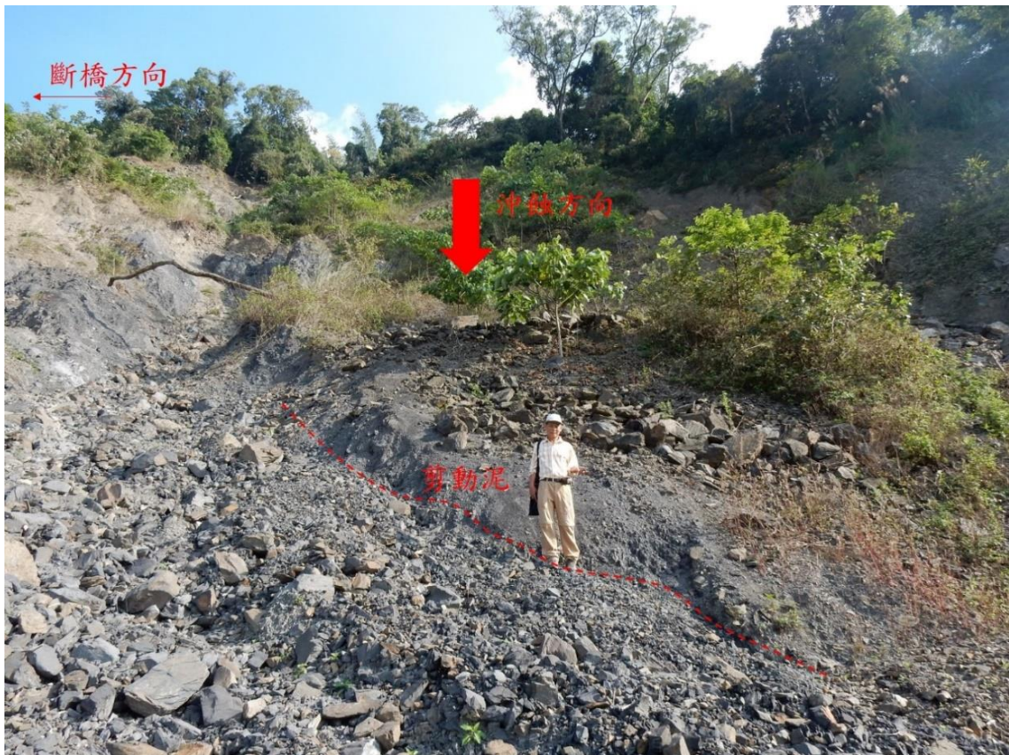
圖 4-25 寶來替代道路道路中斷位置
