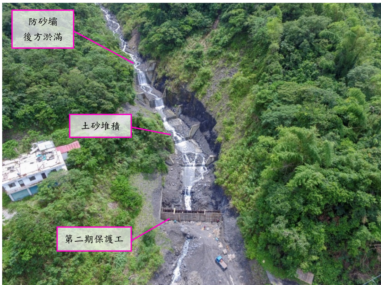
圖 3-17 紅水仙溪崩塌地整治工程空拍(107.9.6)
