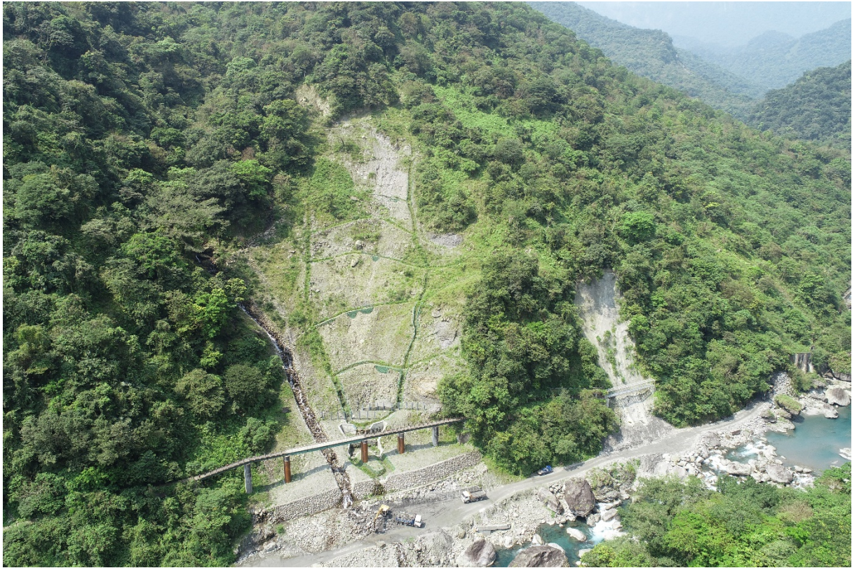
圖 3-42 富源崩塌地處理工程完工後照片(108.3.28)
