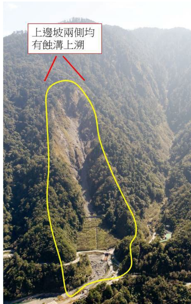
圖 3-4 必坦溪 1 號崩塌地防減災施工前現場照片(106.2.17)
