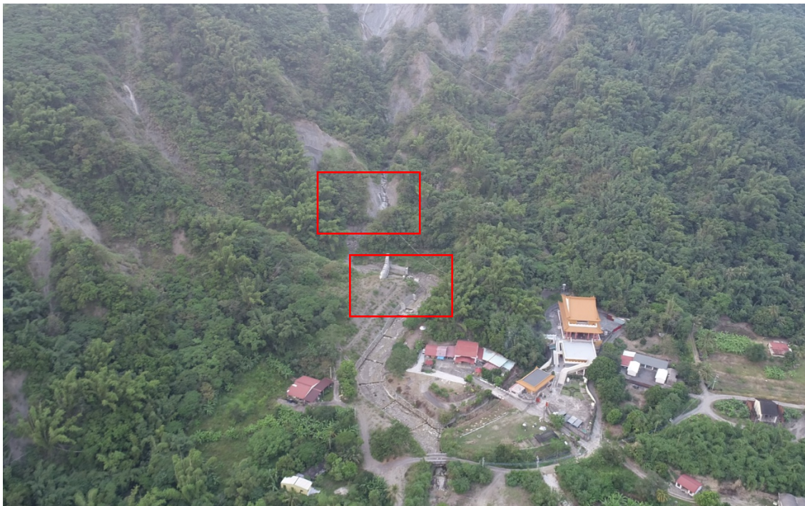
圖 3-31 園緣寺上游崩塌地現況照片(107/10/23)
