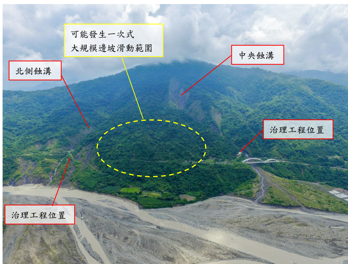
圖 3-24 六龜區-D015 可能發生一次式大規模邊坡滑動範圍
