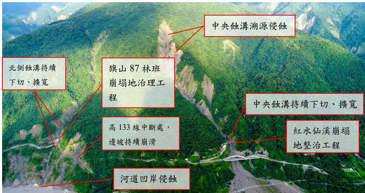
圖 3-16 高雄市-六龜區-D015 防減災工程施工前狀況(106.6.12)
