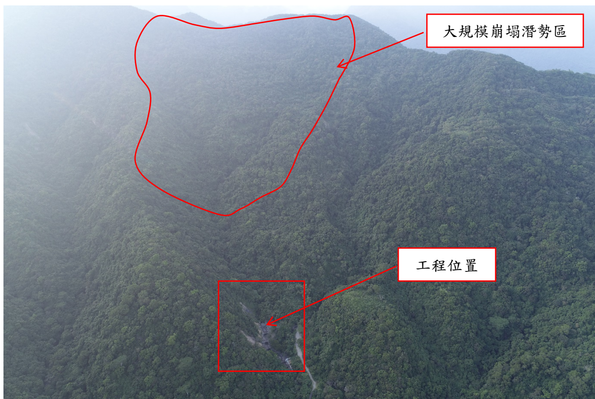
圖 3-55 秀姑巒 63 林班邊坡穩定工程白鹿颱風後整體邊坡現況(108.10.7)
