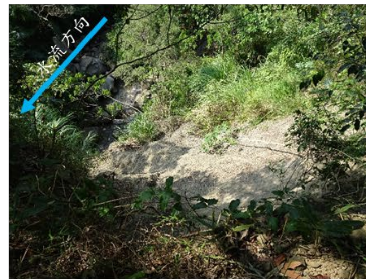
a. 左岸厚層頁岩(SH1)，蝕溝中有水流。
