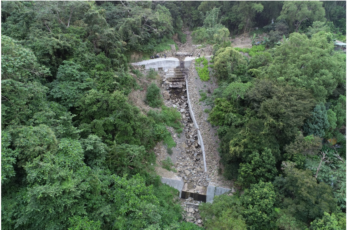
圖 3-32 甲仙區-D040 崩塌區整治工程現況照片(107/10/23)
