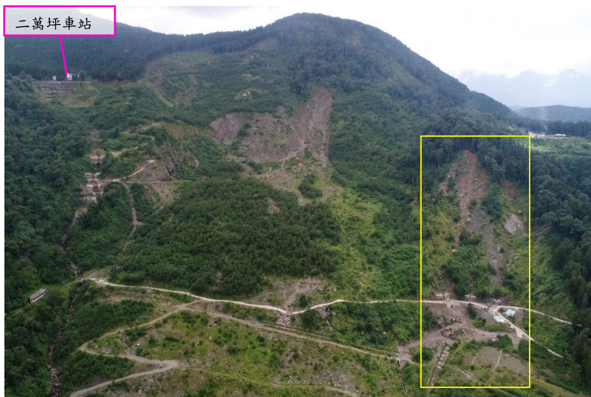
圖 3-12 二萬坪崩塌地防減災工程施工前照片(106.9.8)
