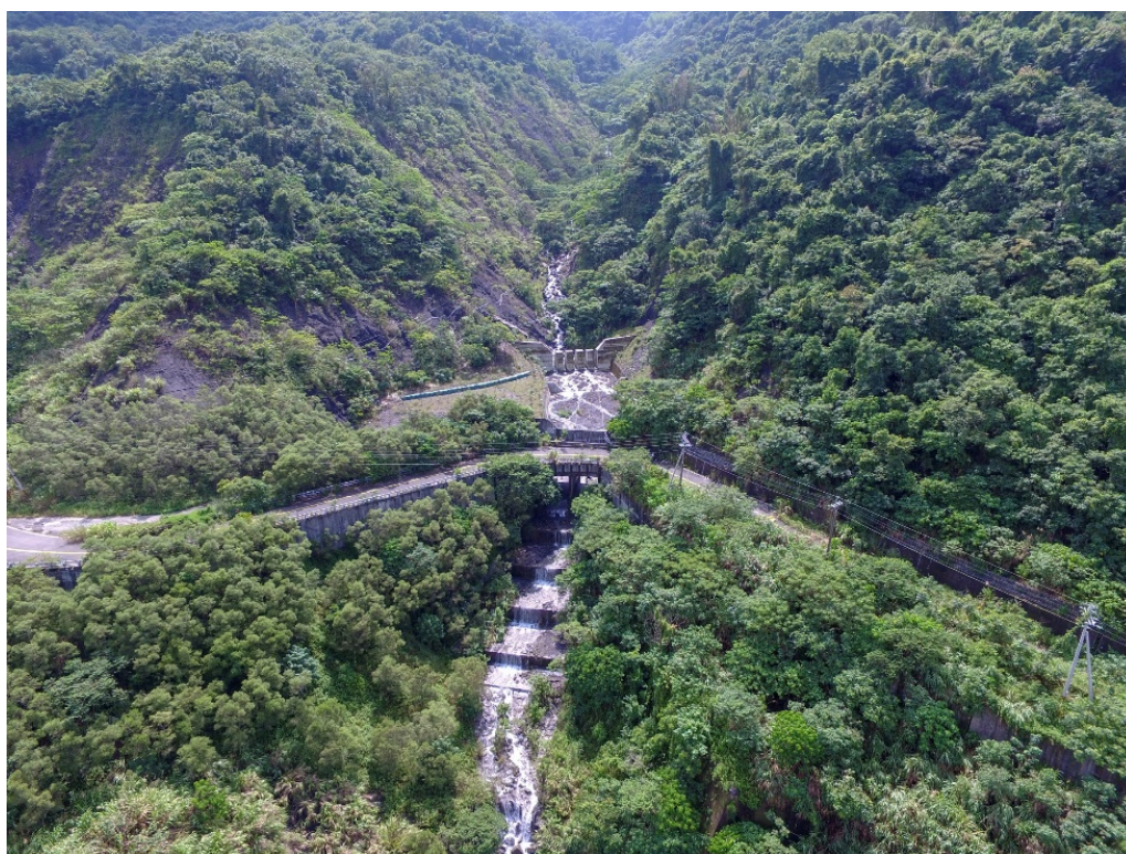
圖 3-19 旗山 87 林班崩塌地治理工程空拍(107.9.6)
