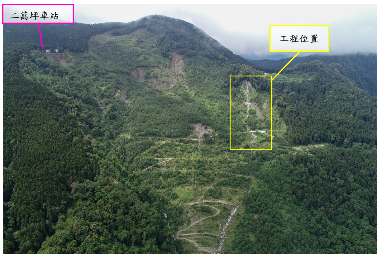
圖 3-13 二萬坪崩塌地防減災工程施工後照片(108.6.22)
