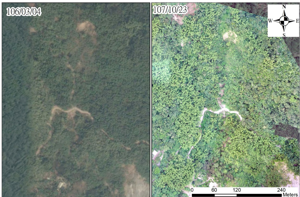
圖 3-33 甲仙區-D040 崩塌區整治工程比較
