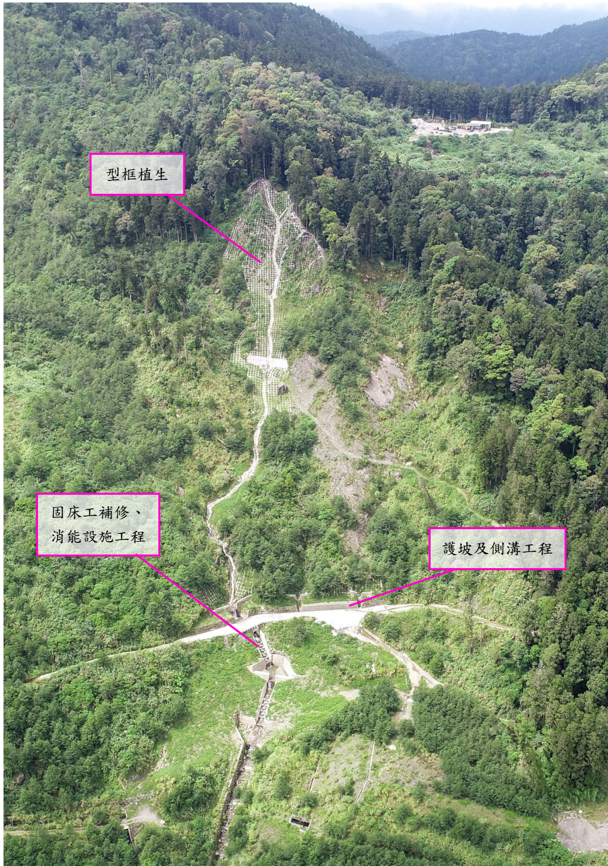
圖 3-14 二萬坪崩塌地防減災工程完工照片(108.6.22)
