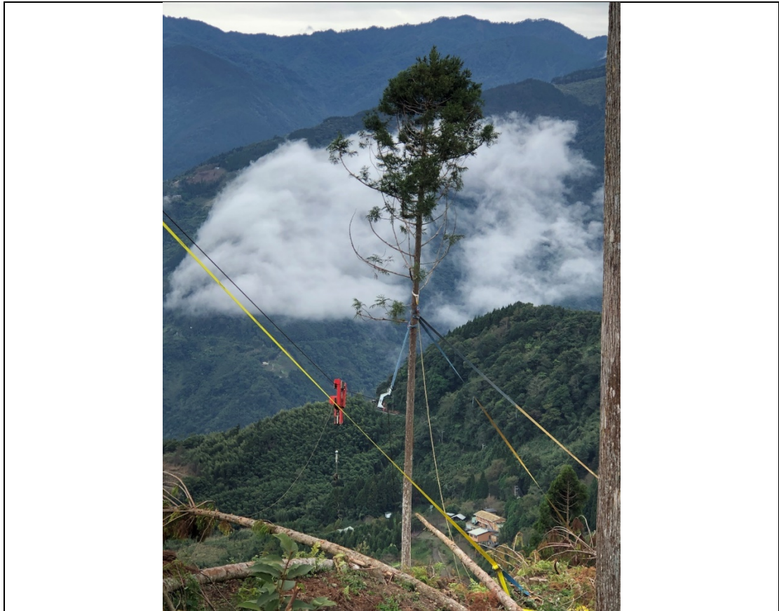
圖 26 集材柱架設
