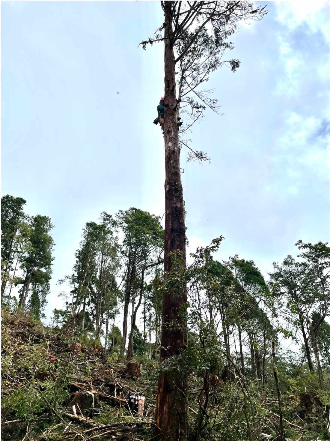
圖 12 架設集材尾柱
