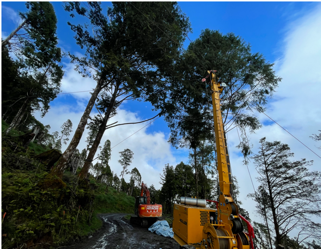
圖 8 和平事業區第 62、65 林班收穫作業 Koller K301-2H 塔式集材機設置
