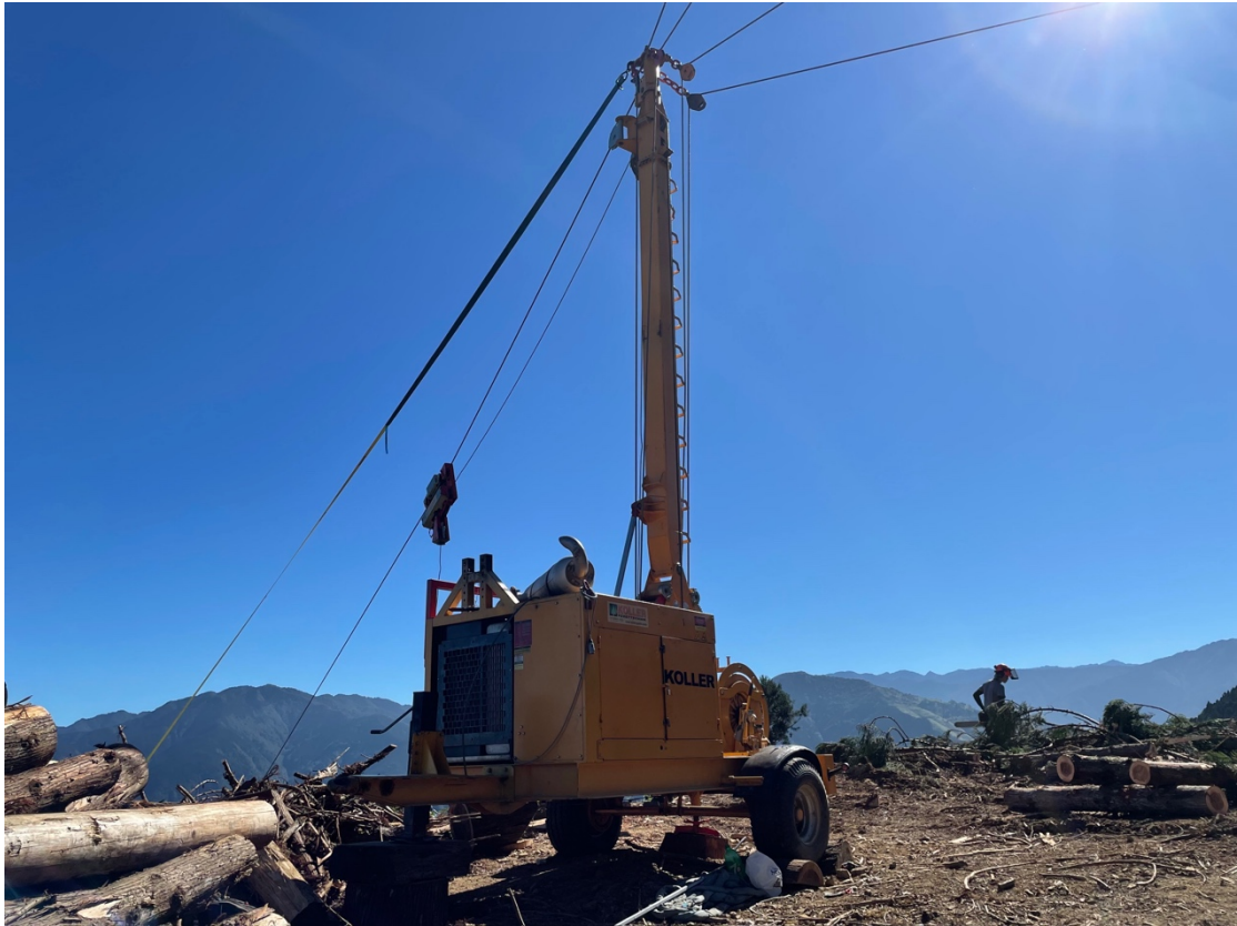
圖 9 竹東事業區第 7 林班收穫作業 Koller K301-2H 塔式集材機設置
