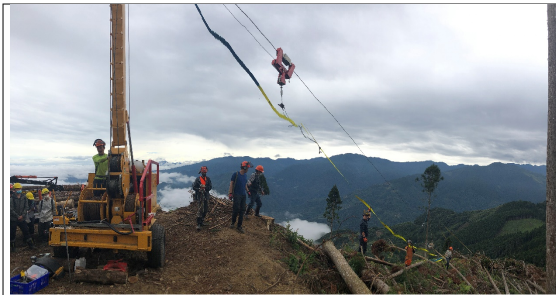
圖 25 集材柱架設實務操作解說
